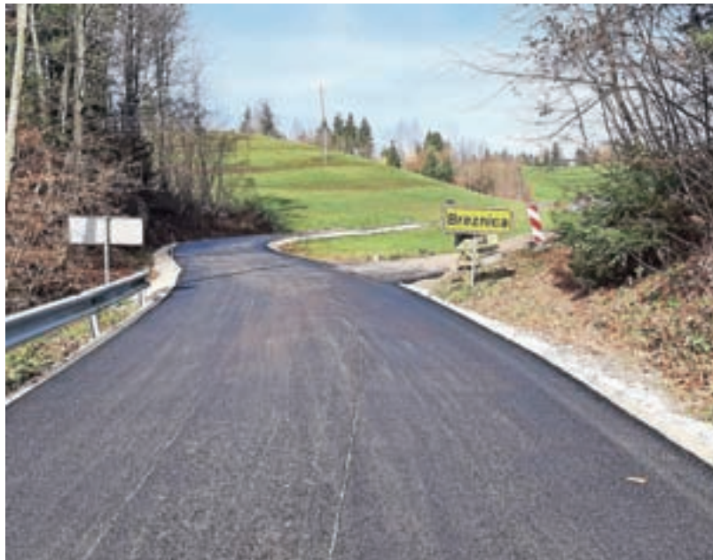
Obnovo je dočakala tudi cesta na Breznici.
